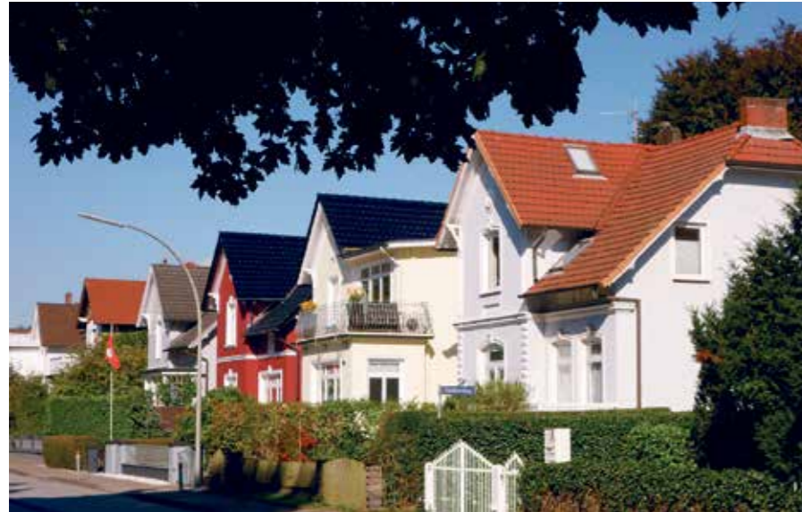
Die Amtsstraße – Architektur aus der Zeit um 1900
