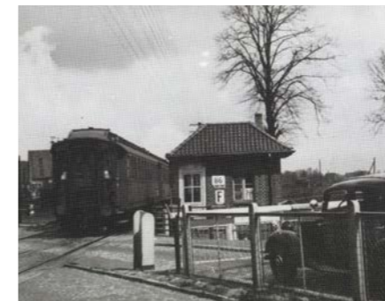
Bahnübergang Tonndorfer Weg* 1952
