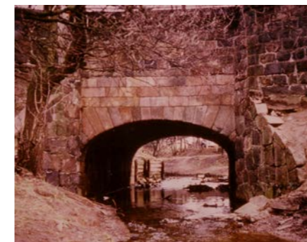
Eisenbahnbrücke mit Halbbogen* 1972
